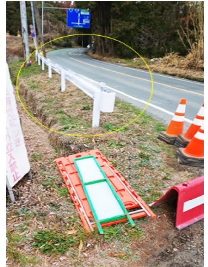
(傾斜した道路 新設されたガードレール)
