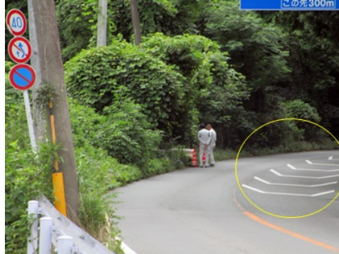
(カーブ部分に塗装された減速標識)
