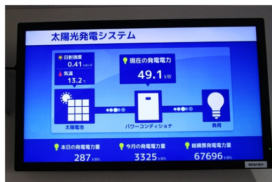
再生エネルギーの活用 (太陽光パネルの設置)
